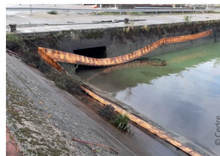
▲ Quai Sud (creux) à marée basse
