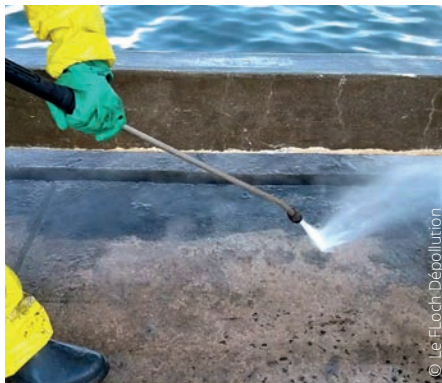
^ Nettoyage à haute pression du quai
