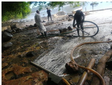
Ci-contre et ci-dessus : décollement du fioul sur racines, par rinçage en basse pression (Source : Polyeco)
