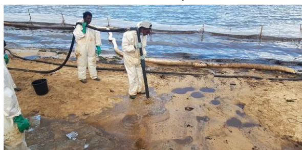
Remobilisation du fioul infiltré dans les sédiments par brassage immergé (ex : front de mangrove à gauche ; plage de sables à droite) (Source : Le Floch Dépollution)
