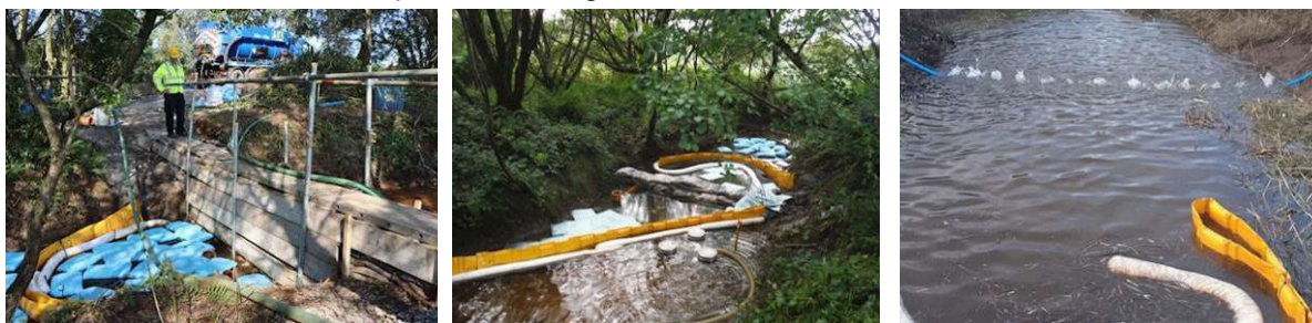
Gche : Confinement par sacs de sable (entre parois de planches), avec barrage flottant et absorbants conditionnés ; Ctre : Dispositif analogue, avec récupération des accumulations flottantes par moyens de pompage + tête d'écumage à seuil ; Drte : Confinement par « rideau de bulles » (Source : Natural Resources Wales)
