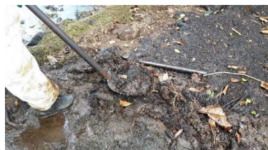
Ci-dessus : collecte manuelle et sélective de la pollution de surface (fioul et débris/déchets souillés) (Source : Le Floch Dépollution) ; ci-contre : Essuyage à l'absorbant de roches calcaires fragiles (île aux Aigrettes) (Source : Polyeco)
