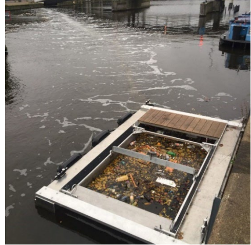
Vue du rideau de bulles déviateur, en surface de l'eau, et du piège flottant (Source : The Great Bubble Barrier )
