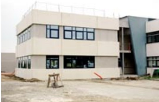
L'extérieur du futur PC intervention
