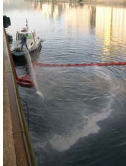
21/01 : Nappe repoussée par lance à eau vers point de pompage (Source : Cedre)
