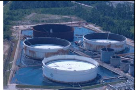
Vue des réservoirs CITGO à l'origine du déversement (Source : USCG).
