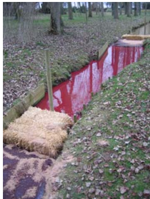
Barrages de fortune : paille (G) ; bois + boudins absorbants (Dte) (Source : Ltn. Langlois - SDIS 44)
