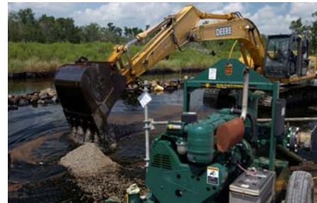
23/06, Indian Marais : limitation de l'étendue de la pollution par édification de remblais (Source : USCG)
