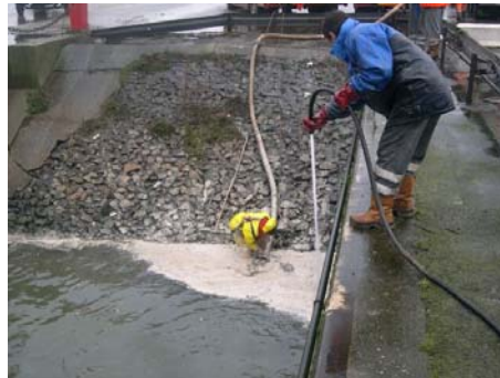
20/01 : aspiration directe et décantation dans les camions (gauche), et concentration du polluant à l'aide d'un jet d'eau (droite) (Source : Cedre)
