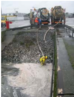
20/01 : aspiration directe et décantation dans les camions (gauche), et concentration du polluant à l'aide d'un jet d'eau (droite) (Source : Cedre)
