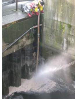
21/01 : Pompage en coin de darse (Source : Cedre)
