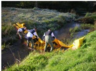
Pose manuelle de la barrière en travers du cours d'eau (Source : Cedre)
