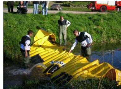
Ouverture d'un clapet de sous tirage (Source : Cedre)
