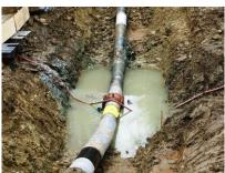
Collier d'étanchéité (en rouge) sur la partie défaillante, en attente d'un remplacement de la section (source : wvxu.org)
