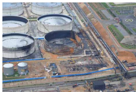
Terminal pétrolier de Dalian : vue du bac de brut lourd incendié (Source : MSA)
