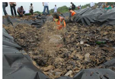
Bioremédiation de sédiments pollués en site contrôlé (épandage de bactéries)
