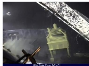
Mise en place des dispositifs d'allègement des soutes du *Oleg Naydenov* (Source : *Ardentia Marine*)
