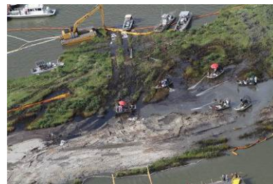
8/9/2016, île-barrière de Chenier Ronquille : Gauche : Confinement par barrages, disposés en épi, de la pollution libre s'accumulant le long du trait de côte ; Droite : Rinçage de la végétation souillée, par jets d'eau en basse pression à partir d'hydroglisseurs ; dispositifs de confinement, sur l'eau, des arrivages de brut remobilisés (Source : www.nola.com/DR )
