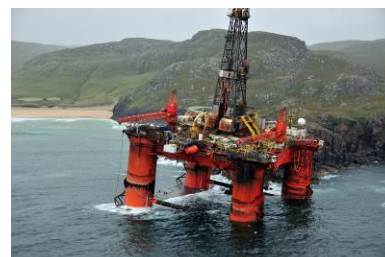
La plateforme Transocean Winner échouée sur l'île de Lewis (source : UKMCA)
