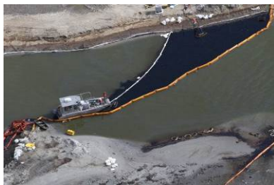
8/9/2016, île-barrière de Chenier Ronquille : Gauche : Confinement par barrages, disposés en épi, de la pollution libre s'accumulant le long du trait de côte ; Droite : Rinçage de la végétation souillée, par jets d'eau en basse pression à partir d'hydroglisseurs ; dispositifs de confinement, sur l'eau, des arrivages de brut remobilisés (Source : www.nola.com/DR )
