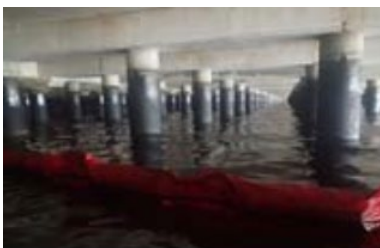
Confinement de fioul flottant piégé sous les quais (sur pieux béton) du terminal pétrolier ATB Vitol (Source : ITOFF)
