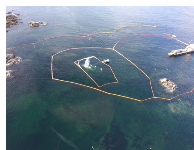
Pose de barrages autour du Nathan E. Stewart submergé (Source : WCMRC)
