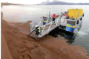
Nettoyage littoral par absorbants en vrac : épandage ( FoxBlower ; gauche) puis mélange ( FoxMix ; droite) des particules (Source : www.henriksen.com )
