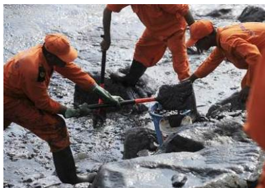
02/02/17 : Ramassage manuel des nappes de fioul en arrivage sur le littoral ( gauche ) ; stockage des déchets liquides en fûts et bidons en arrière plage ( droite ) (Source : PTI) 30/01/17 : Pompage de nappes de fioul libre à proximité d'Ennore (Source : PTI)
