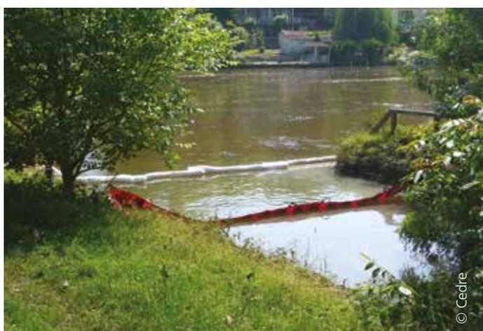
Déploiement de barrages et utilisation d'absorbants sur l'eau
