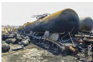
Centrale électrique de Jiyeh après le bombardement Israélien, 2006
