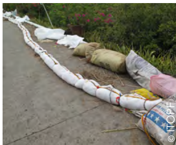
Barrage à façon avec du foin
