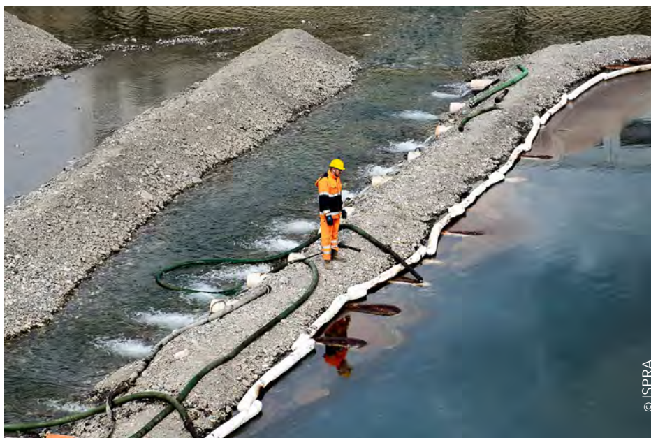
Remblai et tuyaux inclinés afin de filtrer le polluant flottant
